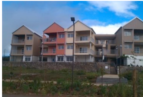
Le Clos des Bancouls 30 logements sociaux
